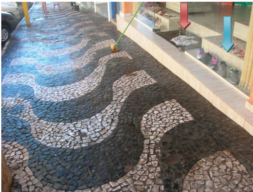
Figura 7- entrada loja 06(difícil acesso para um cadeirante) (Fonte: foto do autor)
