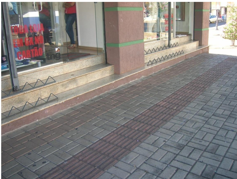
Figura 5 - entrada loja 04 (Acúmulo de araras) (Fonte: foto do autor)
