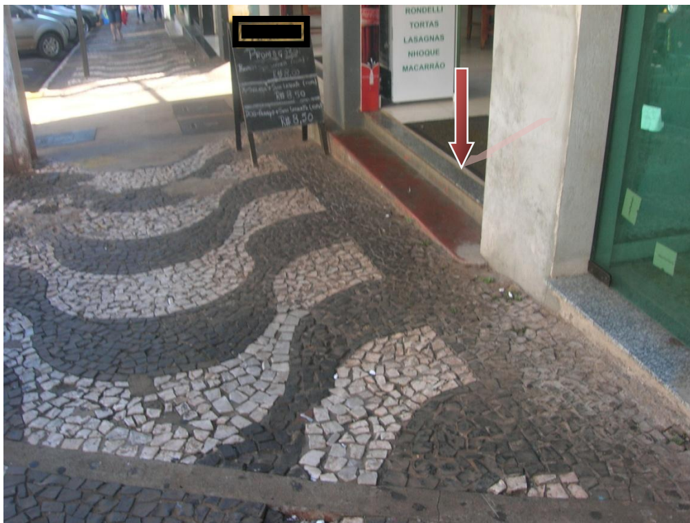
Figura 8- entrada loja 07 - (espaço físico interno mal distribuído) (Fonte: foto do autor)
