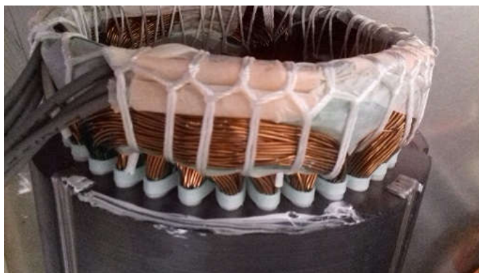
Figura 11 - Falha na bobina da fase
