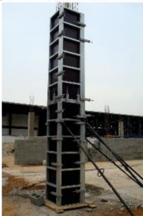
Figura 6 - Disposição de fôrma para pilar final
