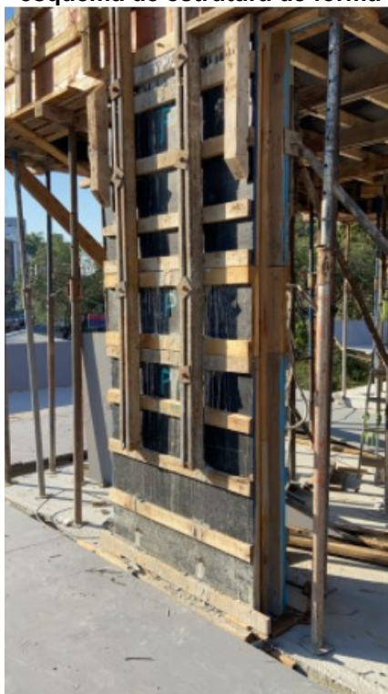
Figura 4 - esquema de estrutura de fôrma para pilar
