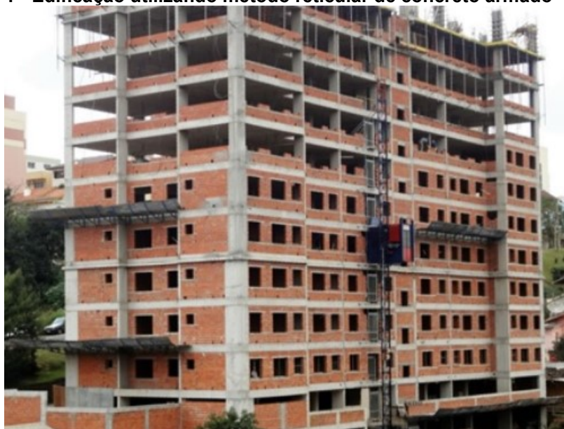
Figura 1 - Edificação utilizando método reticular de concreto armado
