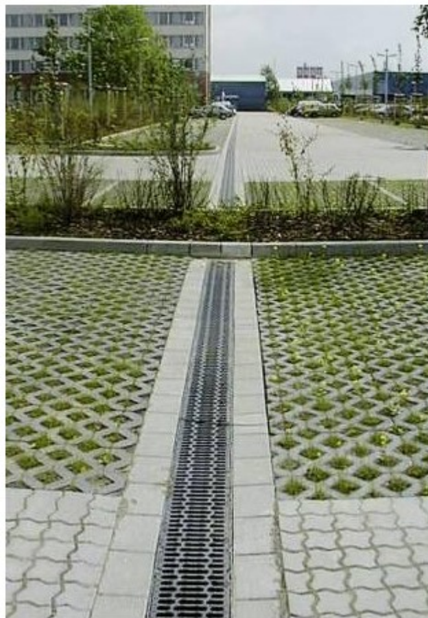
Figura 16 – Combinação entre blocos vazados, pisos intertravados e trincheira de infiltração.
