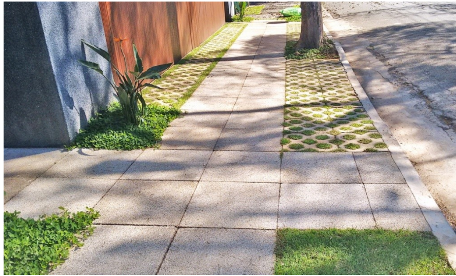
Figura 12 – Exemplo de piso grama na calçada
