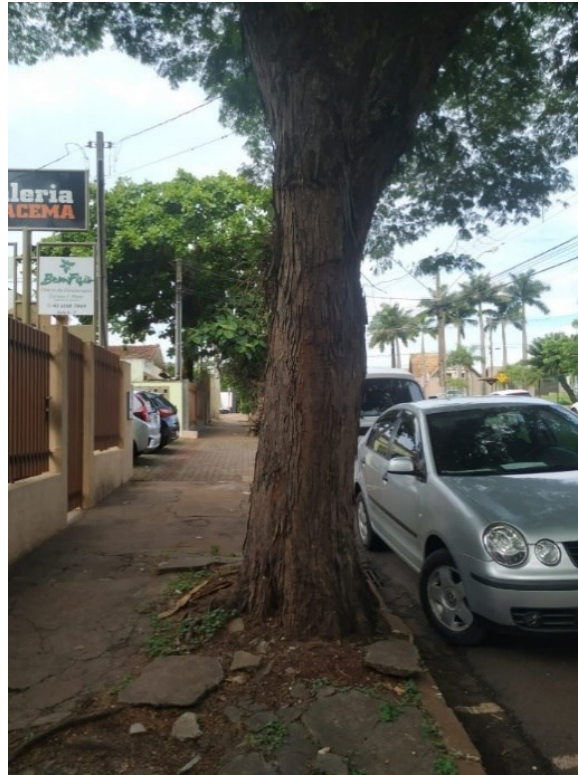
Figura 11 - Exemplo de Sibipiruna com quebra de calçada aparente e área livre insuficiente.
