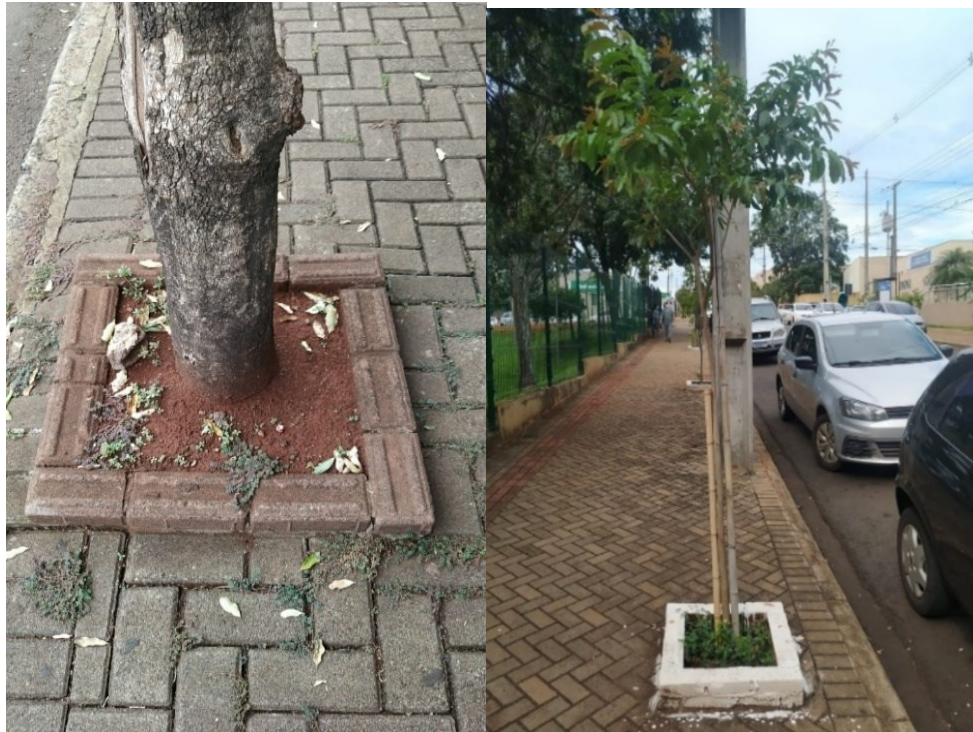
Figura 13 - Exemplos de ocorrência de mureta na arborização urbana de Ibiporã, PR.
