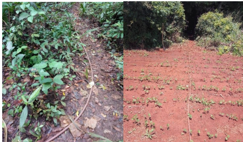
Figura 19 – Caminho da tubulação de recalque a partir do CH
