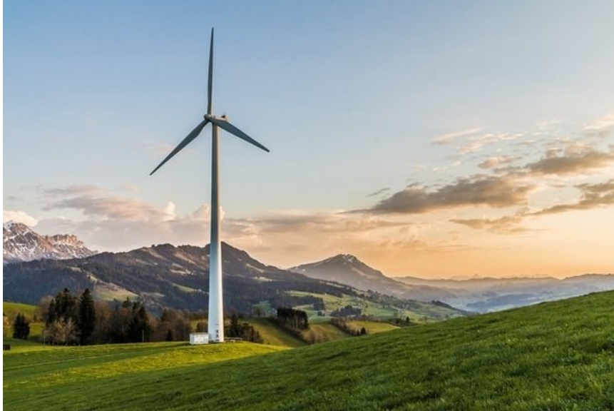
Figura 5: Unidade de geração de energia elétrica. Fonte: Mundo da Elétrica
