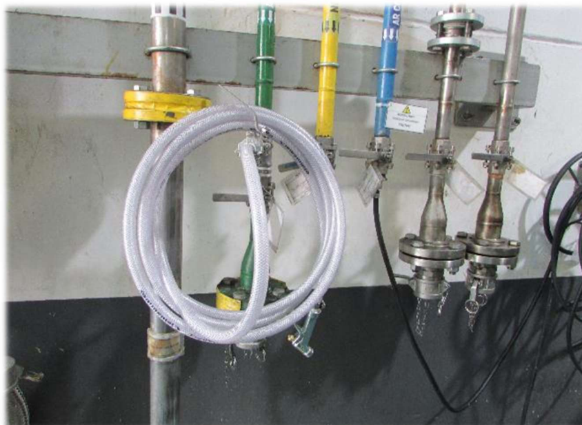
Figura 9 – Novo ponto de água e ar comprimido
