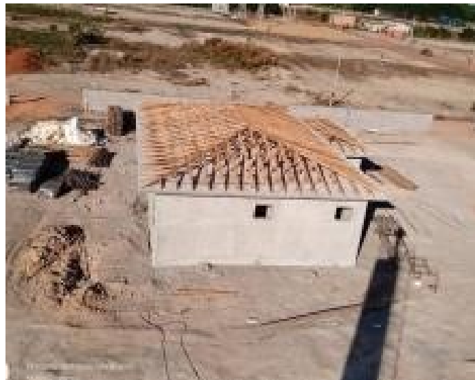
Figura 10 - Cobertura de madeira em sistema ICF Fonte: ICF Construtora Inteligente (2021)
