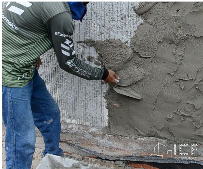
Figura 9 – Aplicação de argamassa de revestimento Fonte: ICF Construtora Inteligente (2021)
