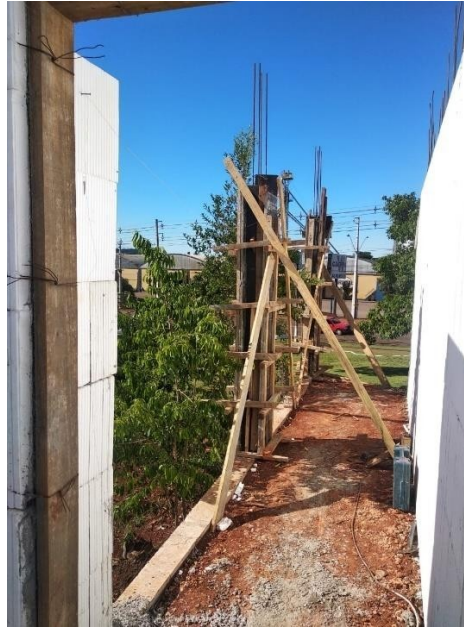
Figura 6 - Sistemas ICF e convencional aliados Fonte: Autoria própria
