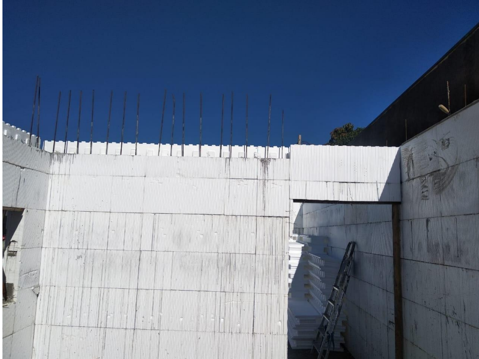
Figura 11 - Parede de ICF com formas prontas para laje Fonte: Autoria própria
