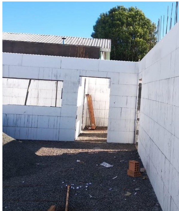
Figura 8 - Aberturas de esquadrias sistema ICF Fonte: Autoria própria
