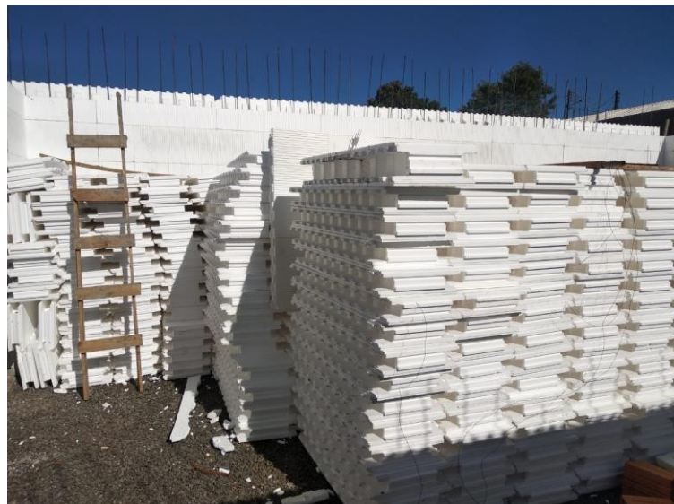
Figura 25 - Disposição das formas ICF no canteiro de obras. Fonte: Autoria Própria
