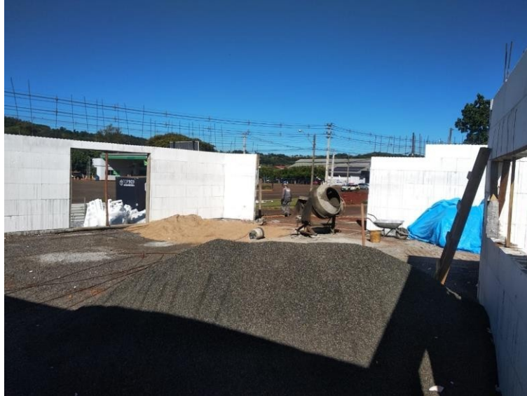
Figura 24 - Canteiro de obras ICF Fonte: Autoria própria
