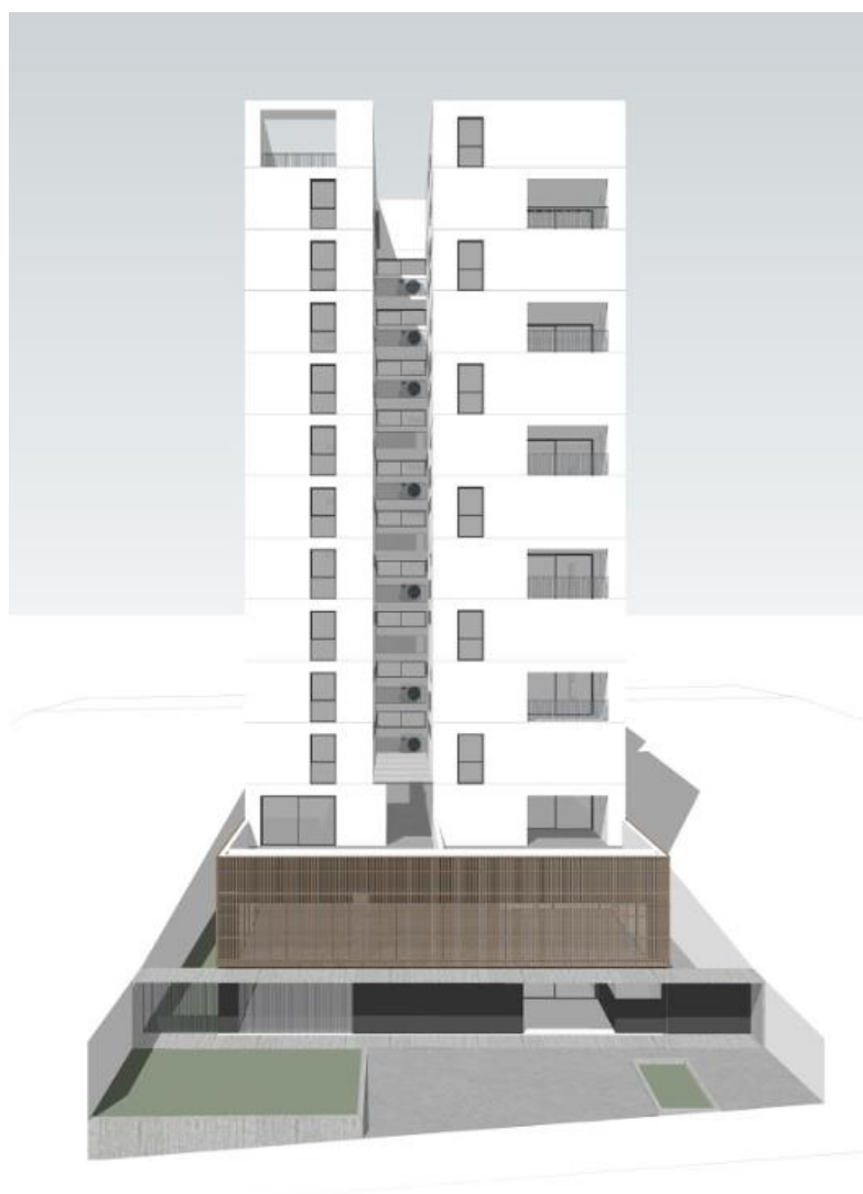
Figura 4: Fachada principal do Edifício. Fonte: COA, 2019.
