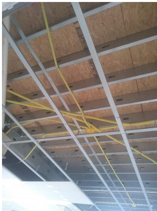
Figura 10: Placa de OSB utilizada como revestimento de cobertura. Fonte: Autoria própria (2019).
