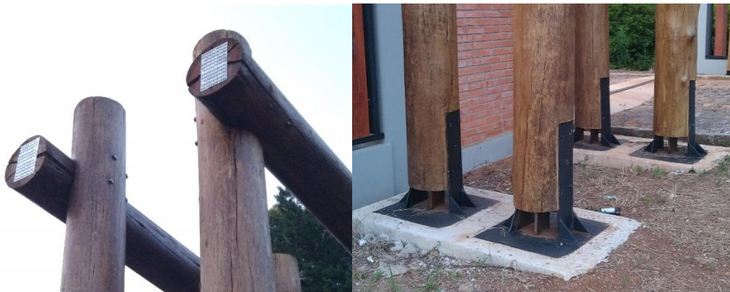
Figura 28: Detalhes da ligação entre as peças de madeira roliça e da base do pórtico espacial
