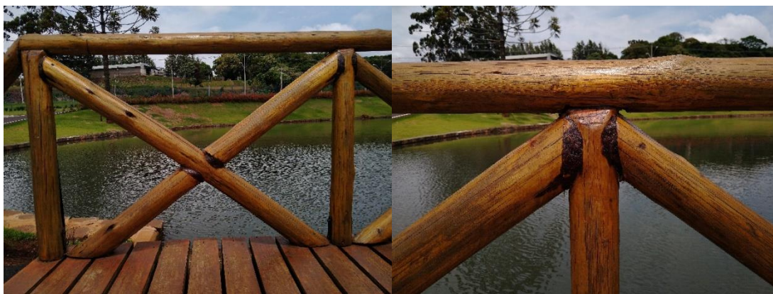
Figura 33: Detalhes da treliça e das ligações utilizadas na ponte em madeira roliça Fonte: Autoria própria (2019).
