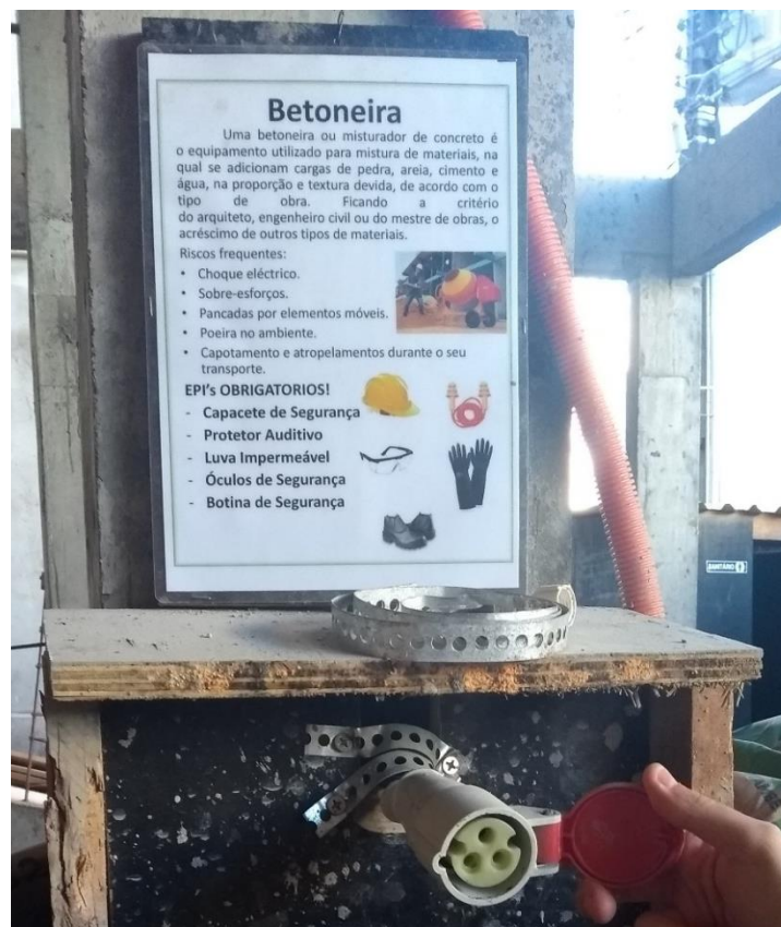
Figura 1: Instruções sobre riscos e EPIs obrigatórios para utilização da betoneira. Fonte: Autoria Própria
