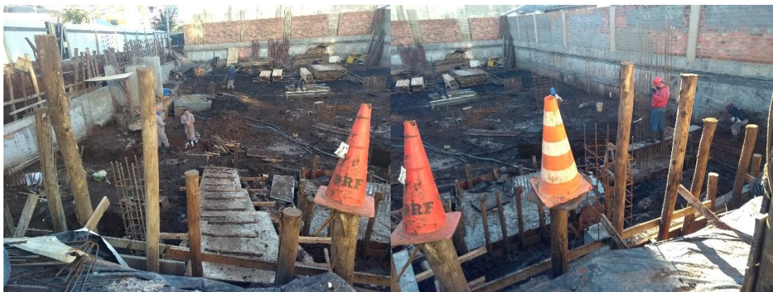
Figura 4: Atividade de escavação e execução de armadura. Fonte: Autoria Própria
