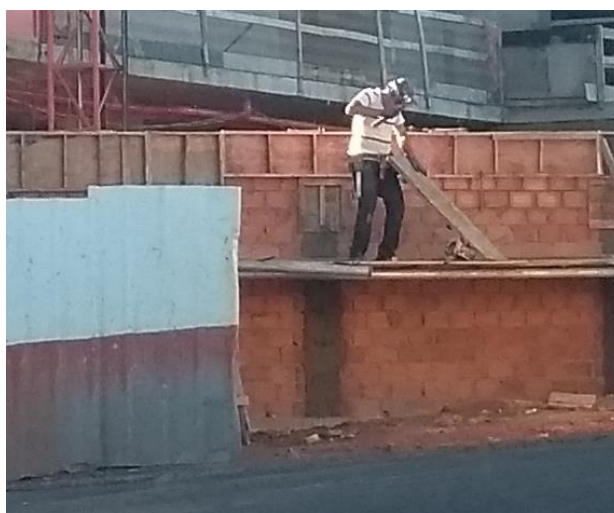
Figura 5: Trabalhador utilizando o corpo como apoio da tábua para martelar prego. Fonte: Autoria Própria
