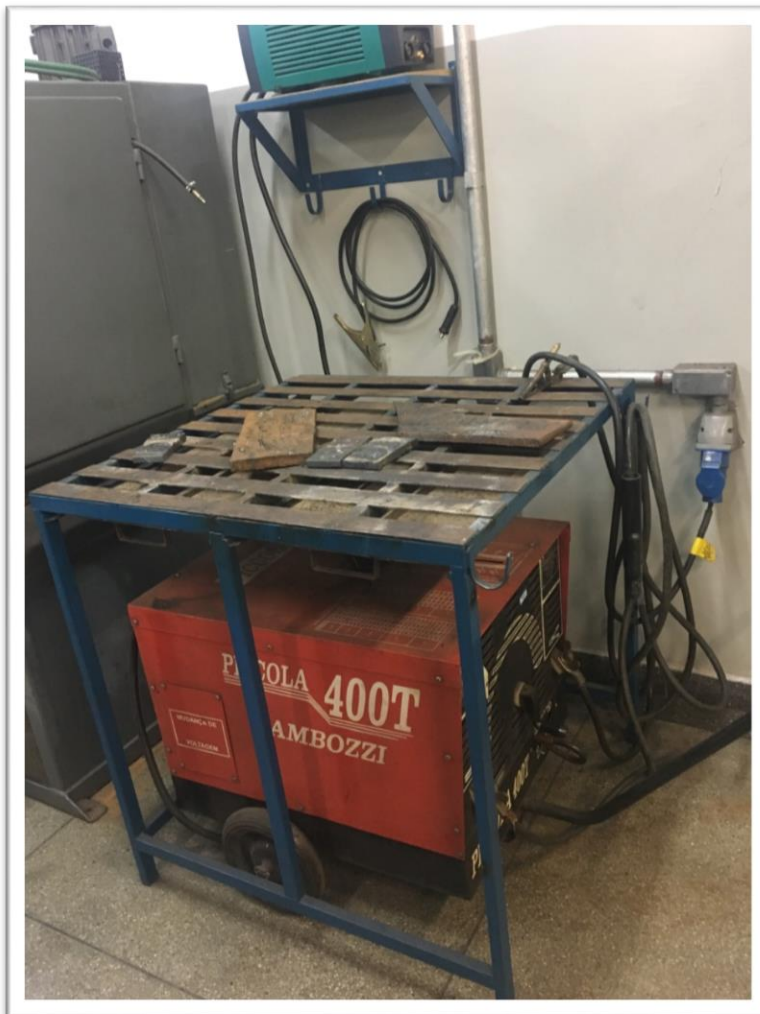
Figura 3 – Equipamento de Soldagem por Eletrodo Revestido. Fonte: Autoria Própria.
