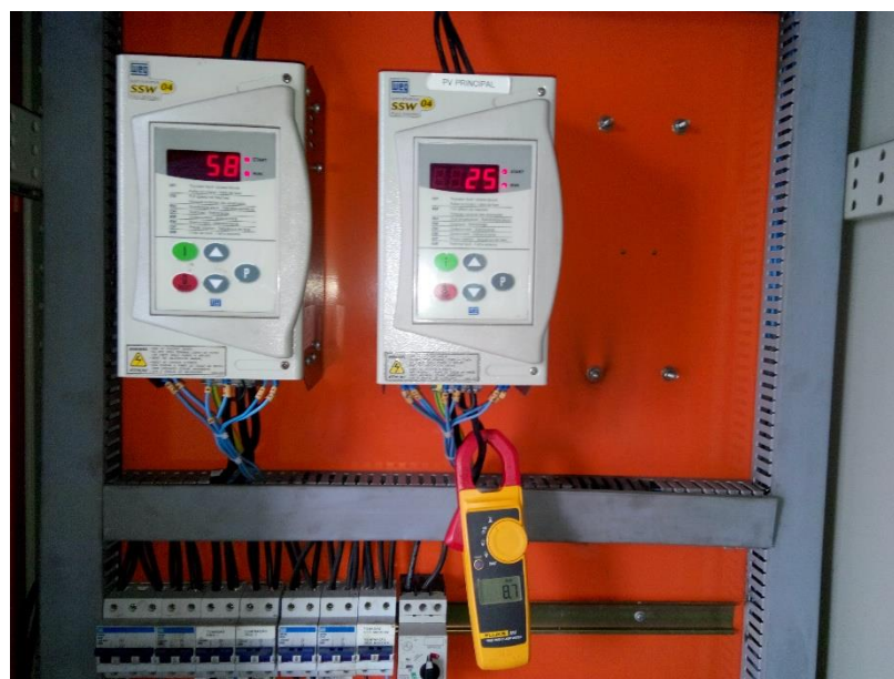
Figura 16 - Medição de corrente no CCM. Fonte: autoria própria
