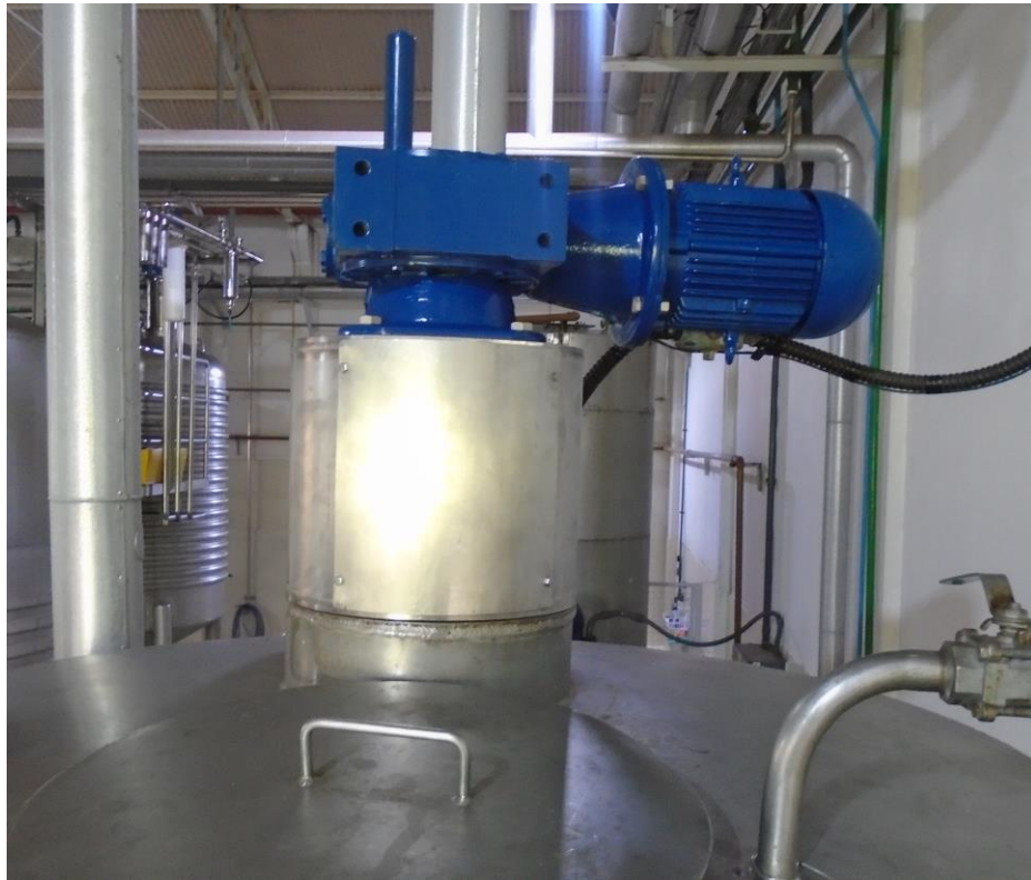
Figura 7 – Projeto executado. Fonte: Autor (2021)
