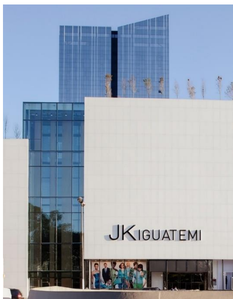
Fotografia 4 - Fachada ventilada com revestimento externo em cerâmica
