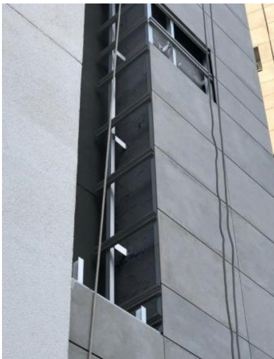
Fotografia 19 – Estrutura de Alumínio da Fachada Ventilada
