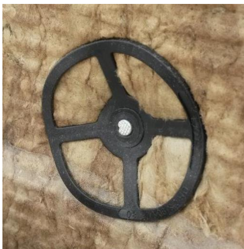
Fotografia 10 – Bucha de fixação de PVC
