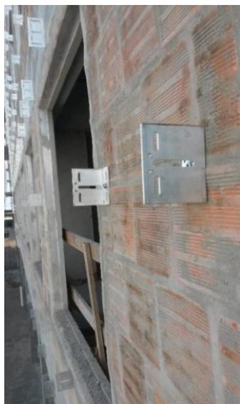
Fotografia 7 – Sistema de ancoragem
