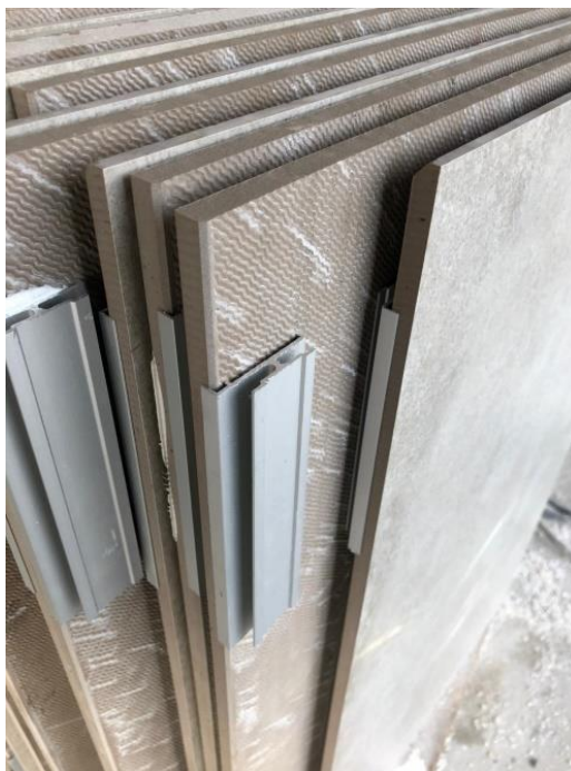
Fotografia 18 – Fixação das placas de revestimento
