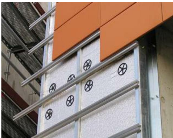
Fotografia 1 – Fachada ventilada com revestimento externo em painéis de poliestireno
