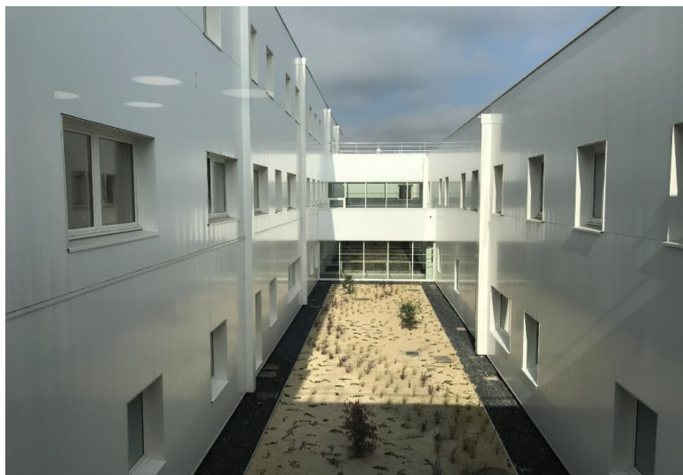
Fotografia 2 – Fachada ventilada com revestimento externo em ACM
