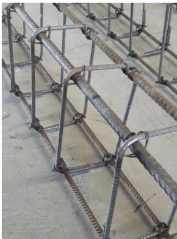
Figura 2 - Armadura de aço
