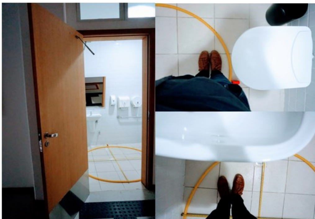
Figura 36 – Medições – Banheiro Acessível 1 (Feminino) – Manobra 360° Fonte: Autoria Própria
