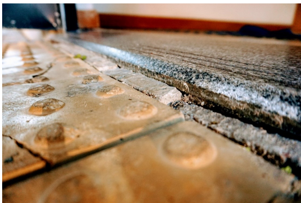
Figura 44 – Obstáculo – Entrada Principal do Bloco Fonte: Autoria Própria
