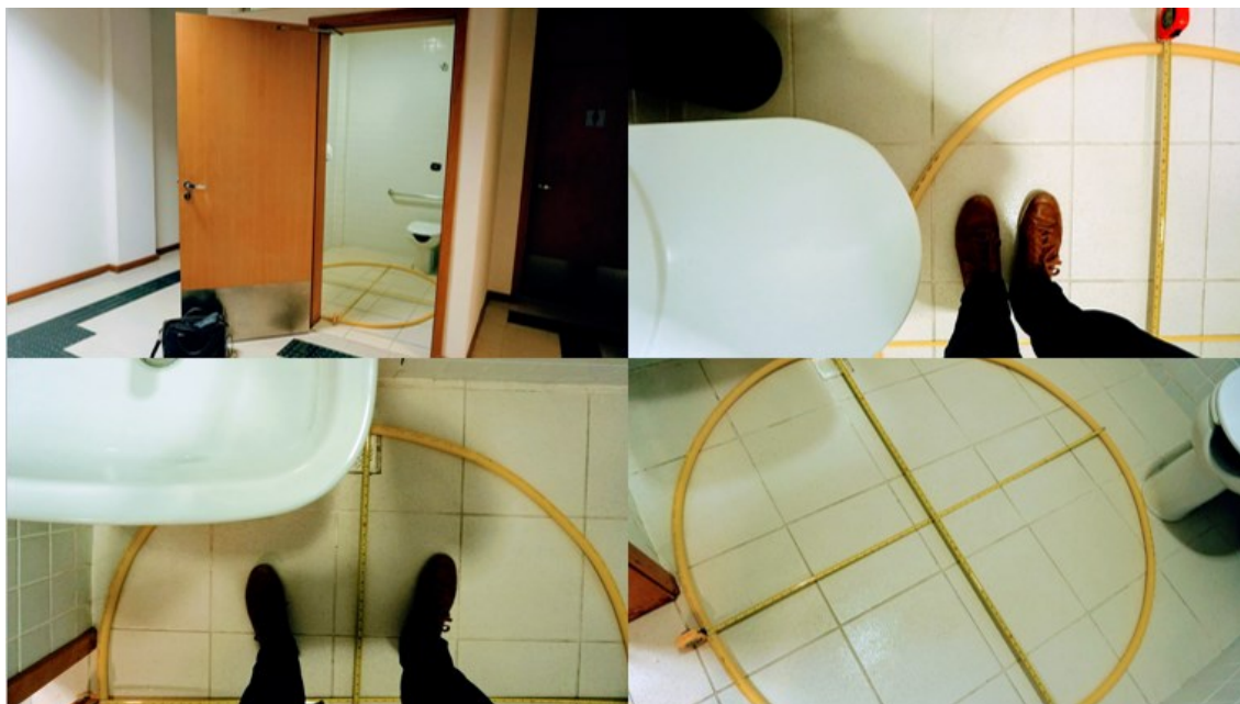
Figura 38 – Medições – Banheiro Acessível 2 (Masculino) – Manobra 360° Fonte: Autoria Própria
