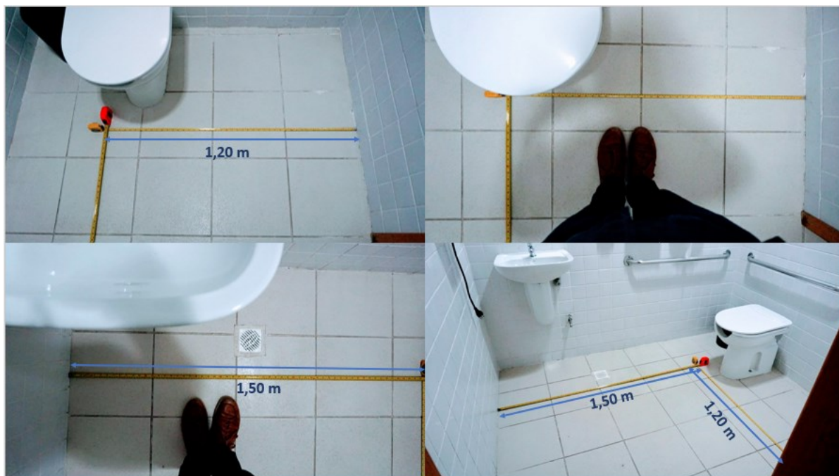
Figura 37 – Medições – Banheiro Acessível 1 (Feminino) – Manobra 180° Fonte: Autoria Própria
