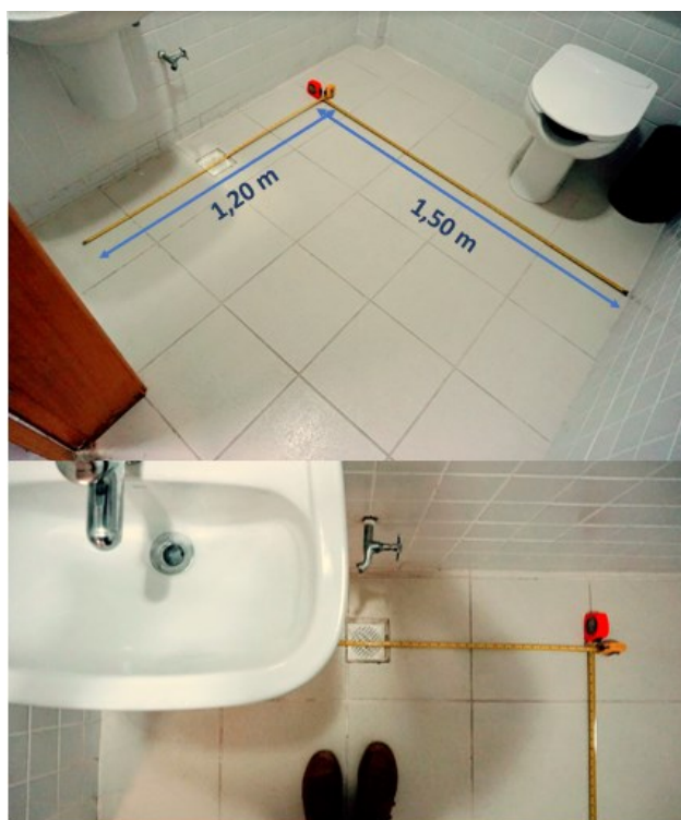
Figura 39 – Medições – Banheiro Acessível 2 (Masculino) – Manobra 180° Fonte: Autoria Própria
