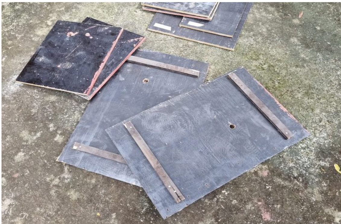
Imagem 1 - Chapas de compensado 18 mm cortadas para montagem da forma do PCG
