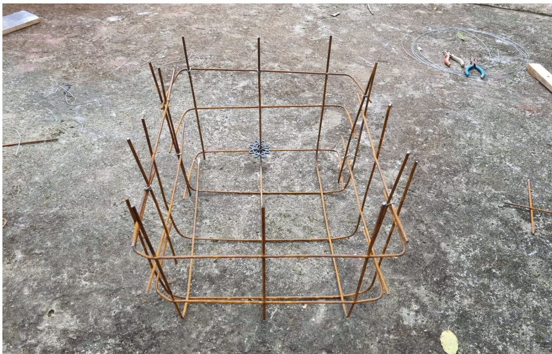
Imagem 3 - Montagem da armadura do PCG e adição de espaçadores
