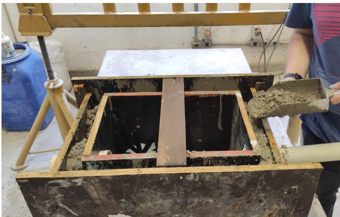
Imagem 6 - Concretagem do PCG
