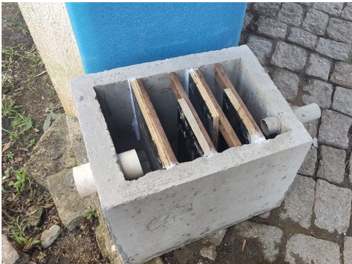
Imagem 9 - PCG finalizado e com chicanas e septo instalados
