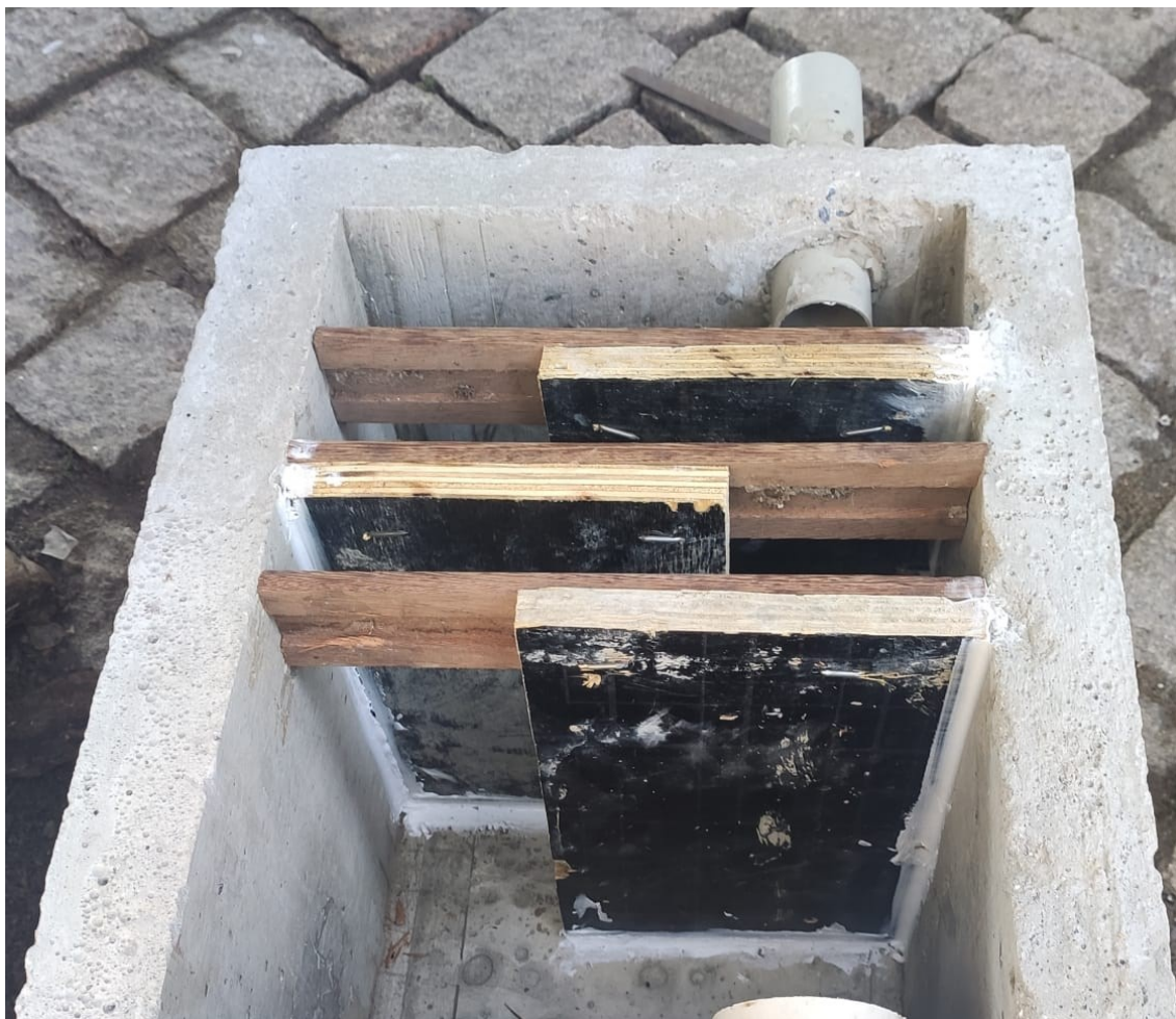
Imagem 8 - Instalação das chicanas
