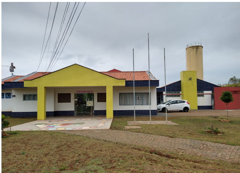
Figura 4 – Creche São João, Pato Branco - PR
