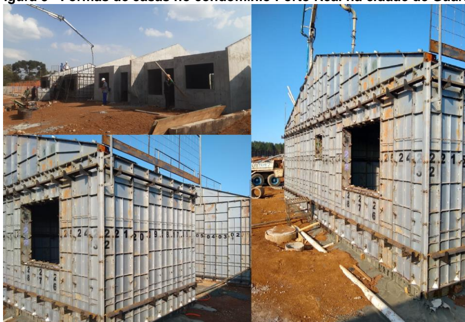
Figura 3 - Fôrmas de casas no condomínio Porto Real na cidade de Guarapuava
