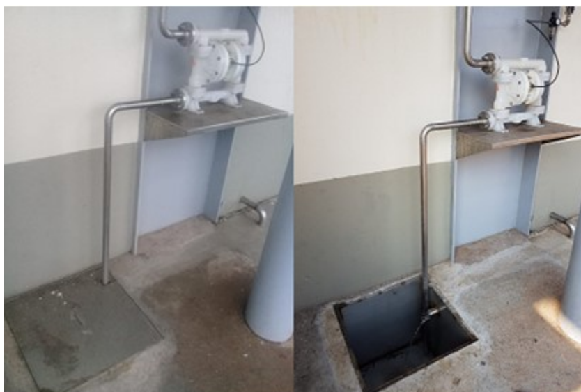
Figura 10 –Água reaproveitada das canaletas e bombeada para Torre de Resfriamento Fonte: Empresa
