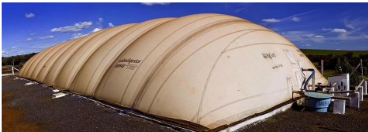
Figura 1 - Modelo de biodigestor fluxo tubular que será utilizado no projeto.
