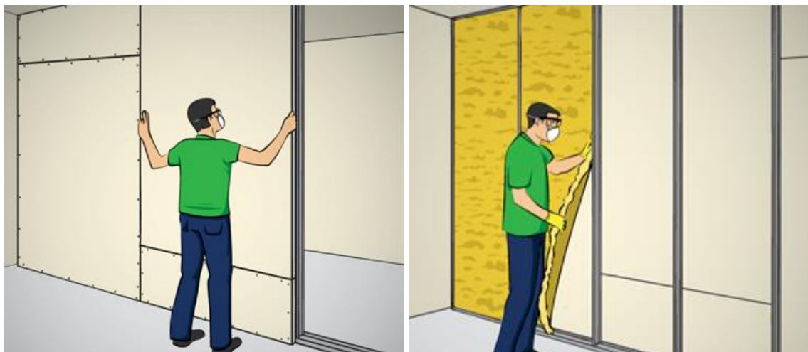
Figura 2.3 – Instalação das chapas do primeiro lado e colocação do isolamento Fonte: Leroy Merlin, 2016.
