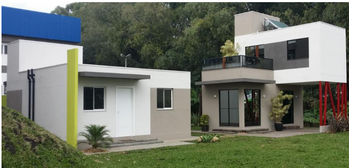
Figura 3.1 – Fachada da Casa 1 (esquerda) e da Casa 2 (direita) Fonte: Autoria própria
