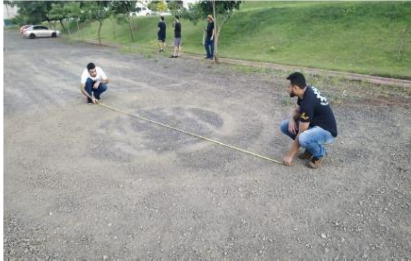
Figura 11 - Verificação do raio de curvatura.
