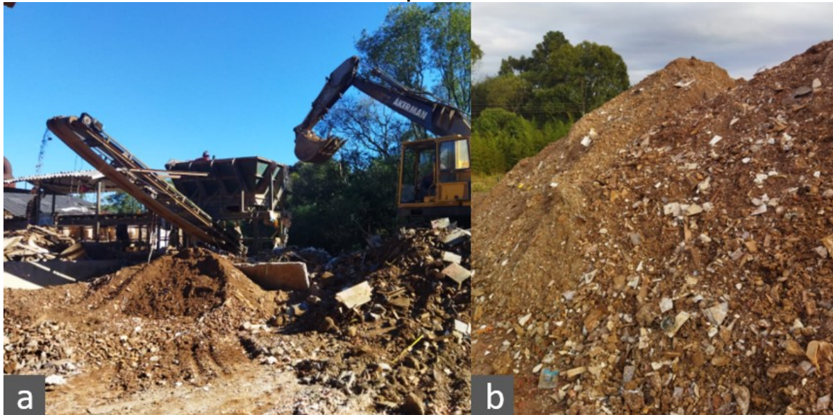
Figura 9 - Processo de retirada de materiais finos dos resíduos. 9a: peneira vibratória; 9b: montes formados pelos materiais finos
