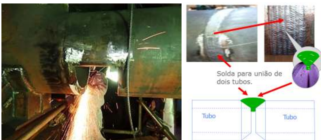
Figura 3 – Exemplos de Solda em Tubulações
