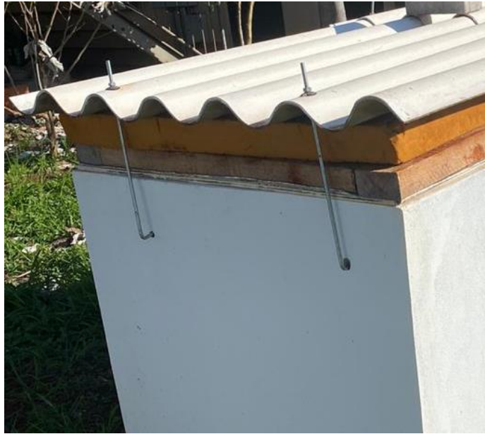
Figura 4: Imagem do isolamento da cobertura
