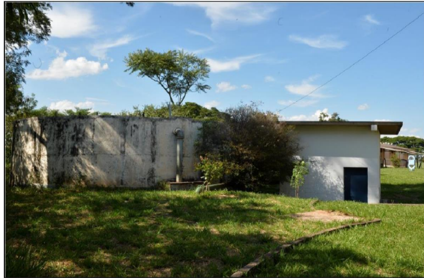
Figura 12 – Vista geral do reservatório apoiado 2 (RAP 2).
