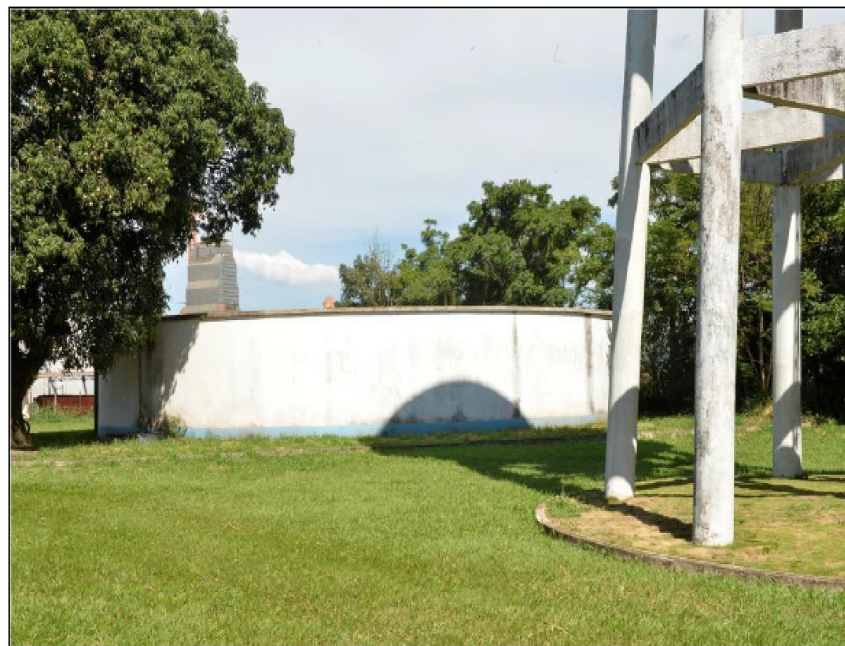
Figura 13 – Vista geral do reservatório apoiado 3 (RAP 3).
