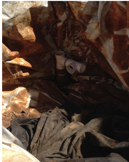
Figura 13 – Construção do sistema de drenagem; (a) Colocação do dreno externo de saída do sistema; (b) Colocação do dreno interno de saída do sistema; (c) e (d) Construção do dreno de coleta; (e) Sistema de drenagem completo.
