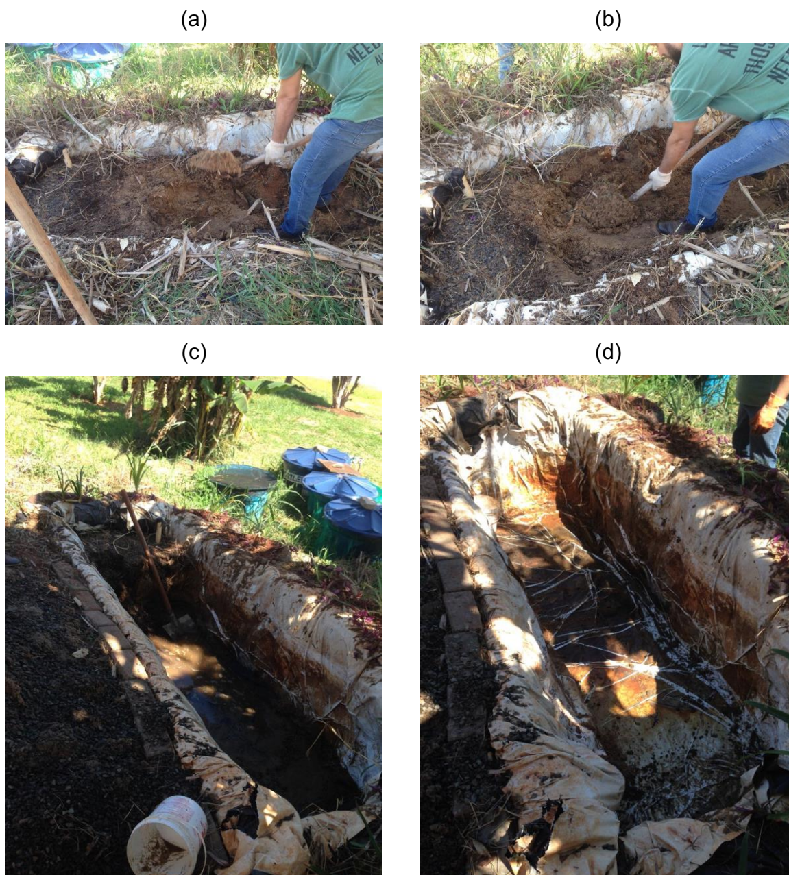
Figura 12 – Remoção do material filtrante do sistema anterior (a) e (b) Remoção da areia utilizada como material filtrante; (c) Vista do leito com pouco material filtrante; (d) leito limpo após remoção de todo material filtrante.
