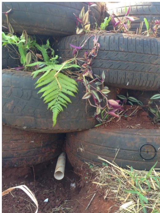
Figura 13 – Construção do sistema de drenagem; (a) Colocação do dreno externo de saída do sistema; (b) Colocação do dreno interno de saída do sistema; (c) e (d) Construção do dreno de coleta; (e) Sistema de drenagem completo.
