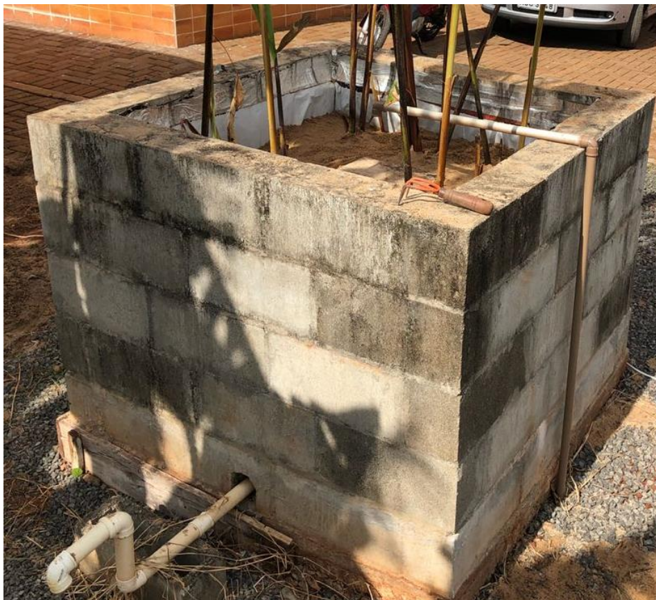
Figura 16 – Estrutura de tijolos de concreto e aço do Estágio 2 do Wetland construído.
