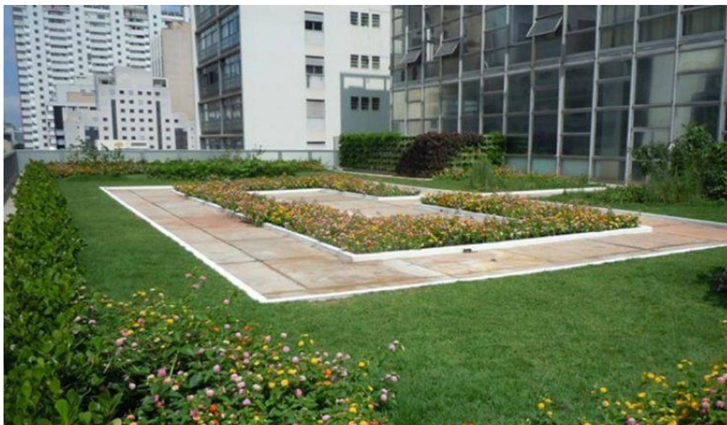
Figura 15 - Telhado verde no edifício da Fundação Casper Libero em São Paulo
