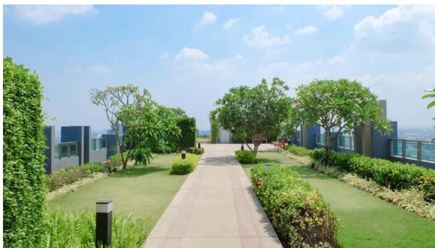
Figura 5 - Sistema de telhado verde intensivo
