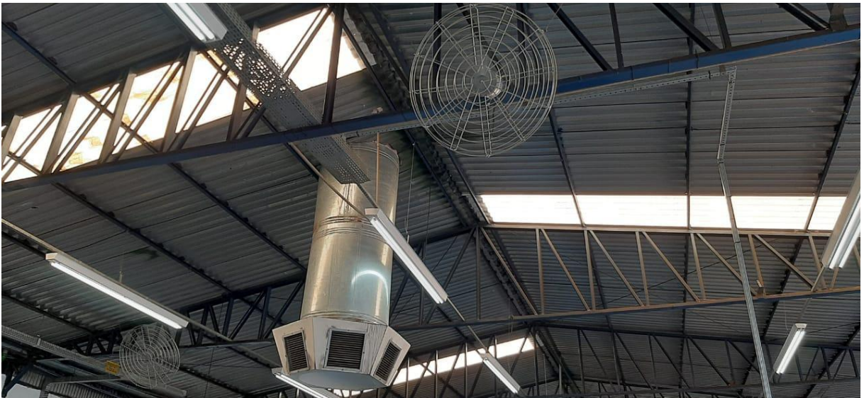
Figura 25 - Instalação de ventiladores, sistema de climatização e melhoria da iluminação
