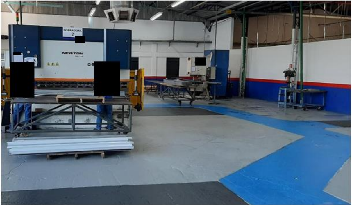
Figura 24 - Pintura geral do setor
