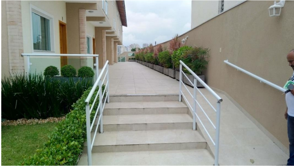
Figura 17: Rampa e escada situada ao final da rota de fuga. Fonte: Autoria própria
