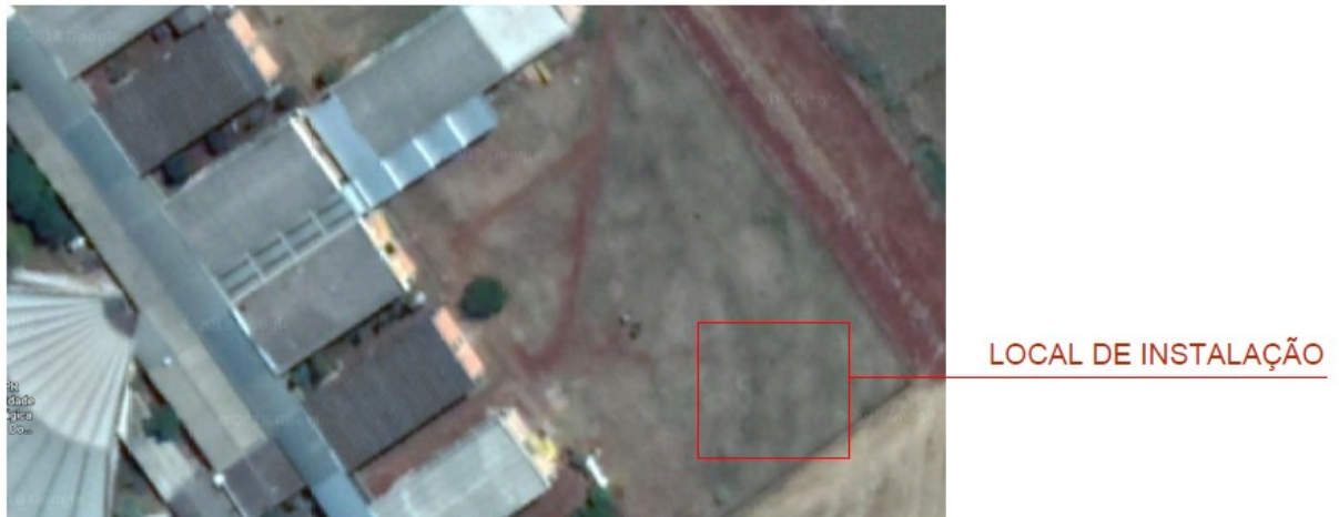
Figura 8 – Vista aérea do local de instalação do sistema fotovoltaico
