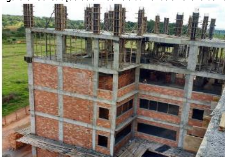
Figura 3: Construção de um edifício utilizando alvenaria de vedação.
