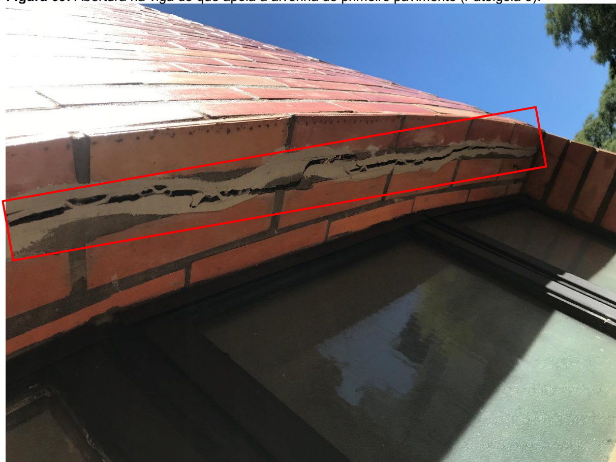
Figura 69: Abertura na viga do que apoia a alvenria do primeiro pavimento (Patolgoia 5).
