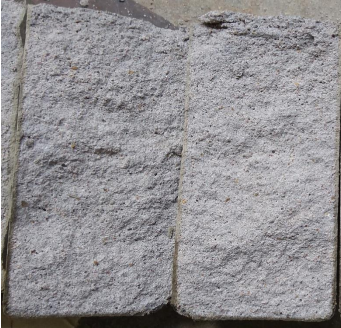
Figura 13 - Corpo-de-prova com impermeabilizante rígido.
