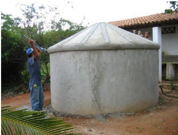
Figura 10. Cisterna de tijolos
