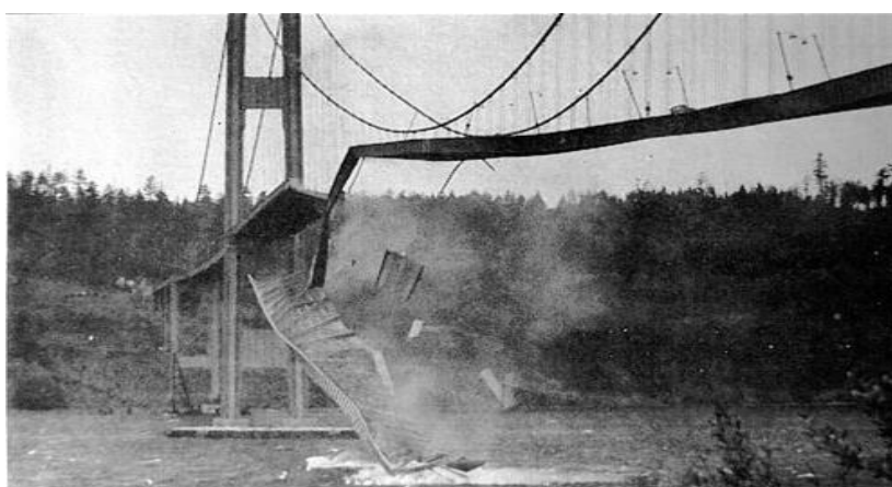
Figura 2 - Ponte de Tacoma durante vibração induzida pelo vento. Fonte: Rao e Singiresu (2008)
