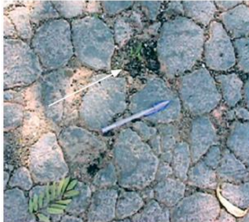
Figura 29 - Couro de jacaré com erosão (JE)
