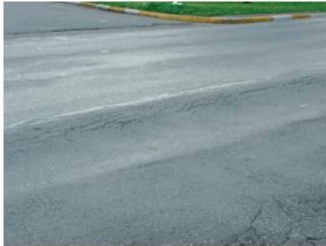
Figura 31 - Afundamento (A)
