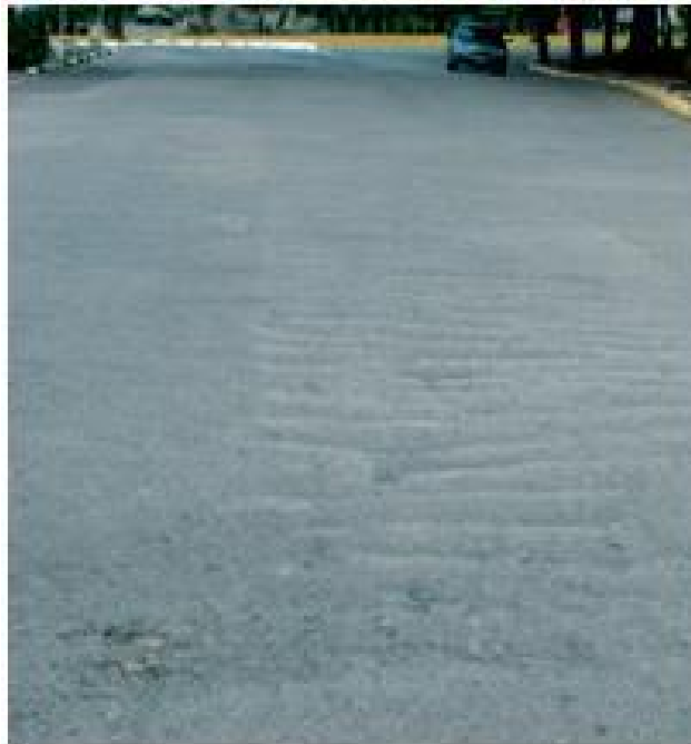
Figura 32 - Corrugação/ondulação (O)
