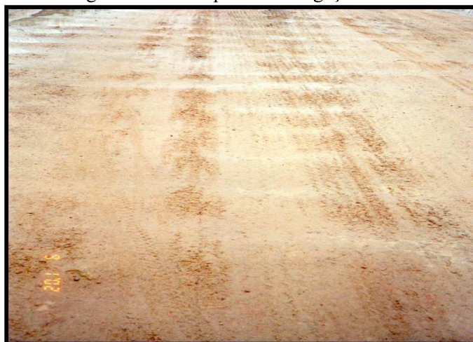
Figura 10 - Exemplo de corrugação na via
