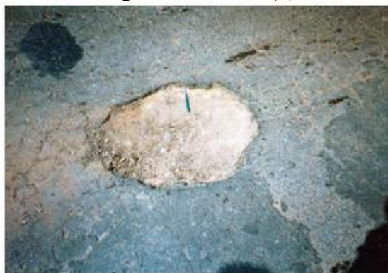
Figura 35 - Panelas (P)
