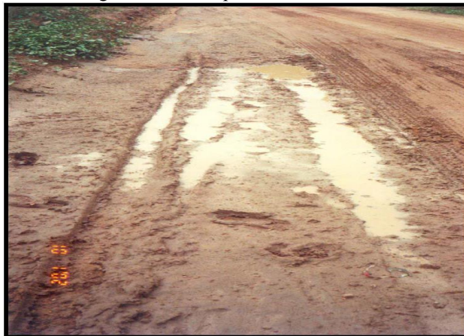
Figura 14 - Exemplo de trilhas de roda
