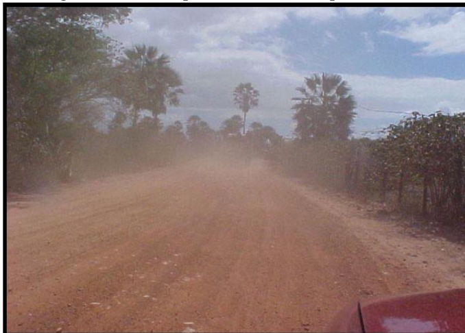
Figura 13 - Exemplo de excesso de poeira na via
