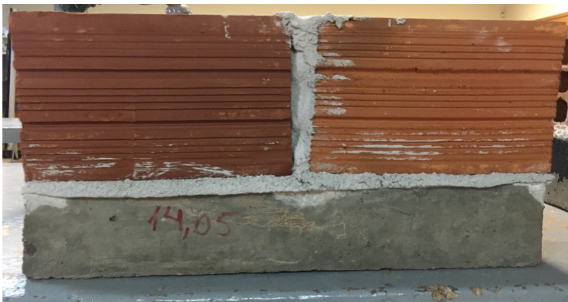
Figura 11: Viga baldrame sem impermeabilização após a exposição a água.
