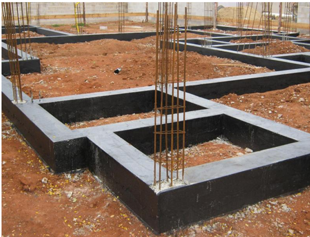
Figura 1: Viga baldrame impermeabilizada
