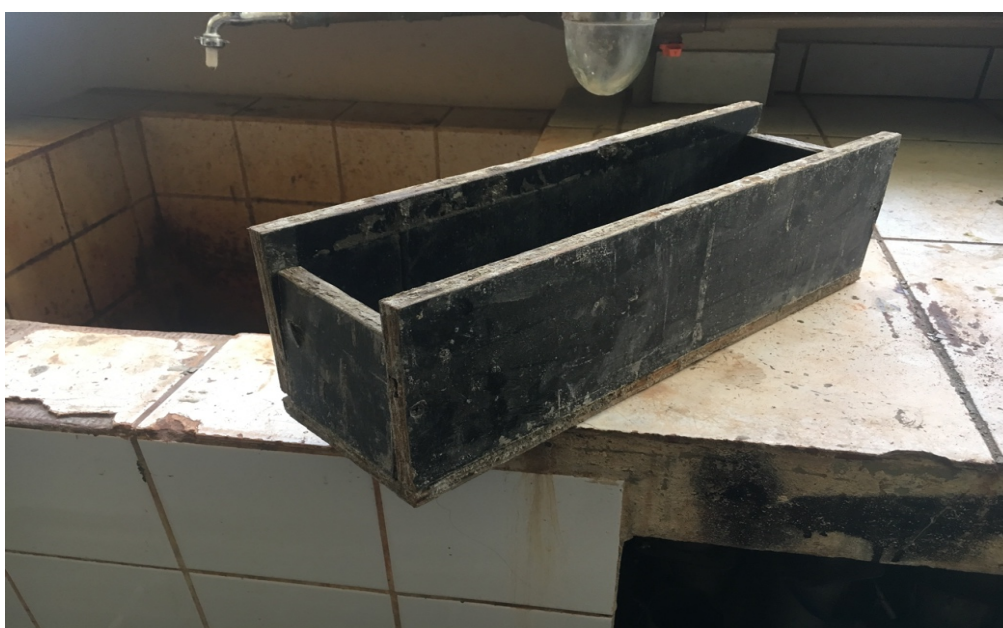
Figura 7: Forma para a concretagem da viga baldrame.
