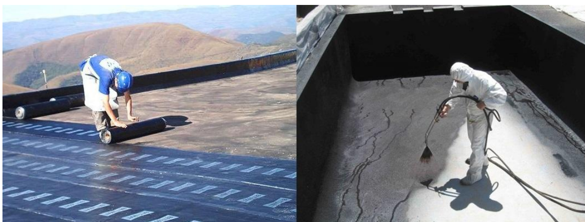
Figura 2: Impermeabilização Flexível X Impermeabilização Rígida.
