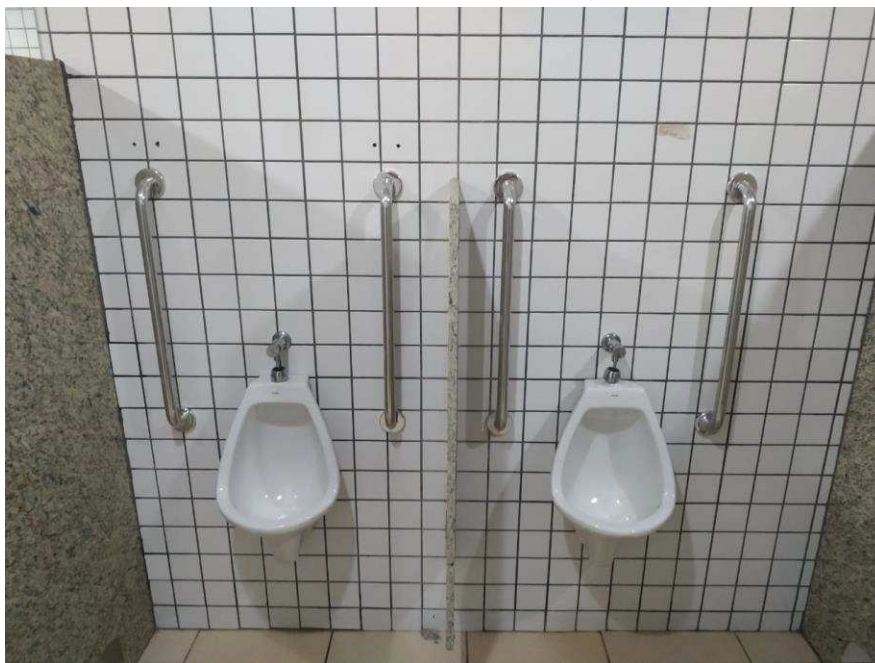
Fotografia 5 – Mictórios do banheiro do térreo
