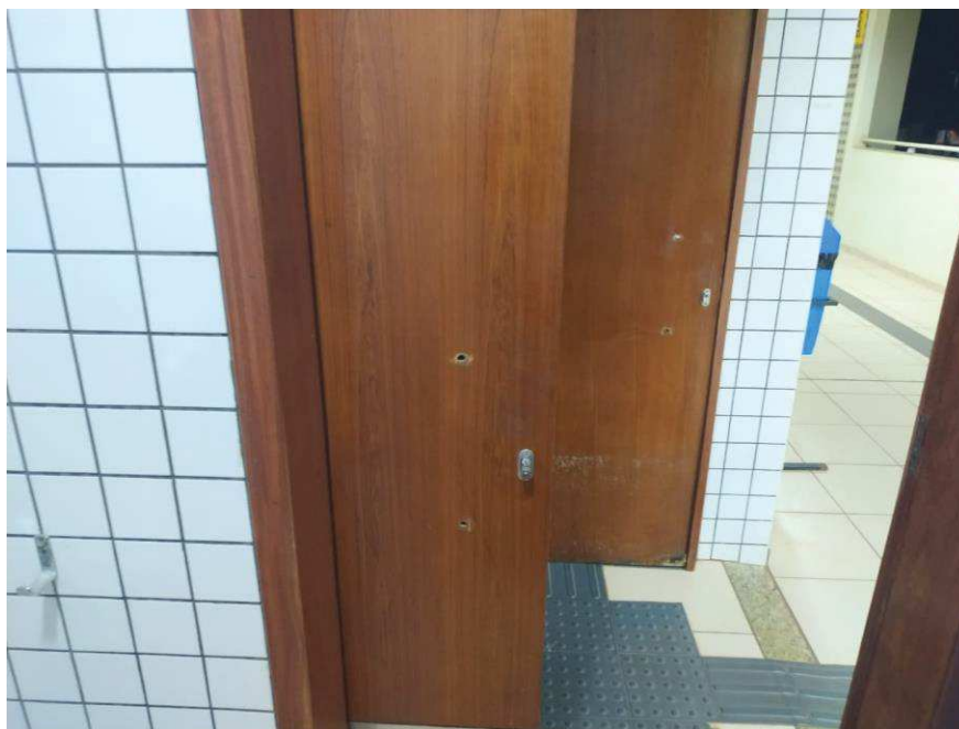
Fotografia 8 – Portas dos banheiros acessíveis do segundo pavimento
