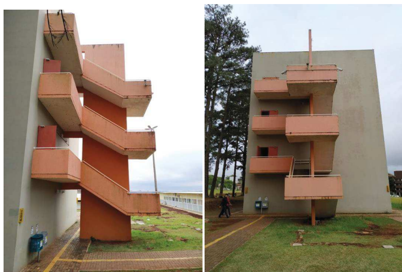
Fotografia 12 – Vista lateral e frontal da escada externa
