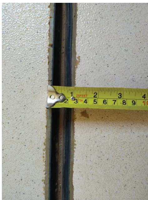
Fotografia 23 – Junta de dilatação
