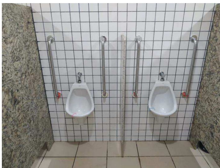
Fotografia 10 – Mictórios do segundo pavimento
