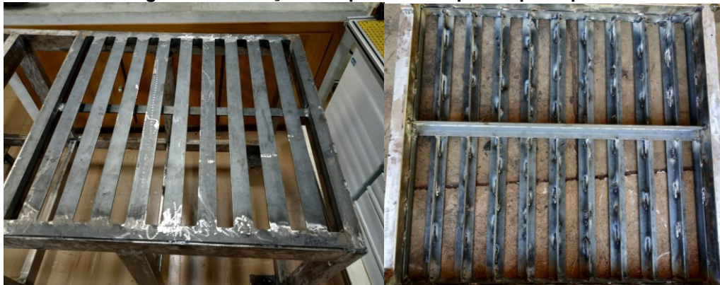
Figura 20 - Fixação dos perfis T no quadro principal
