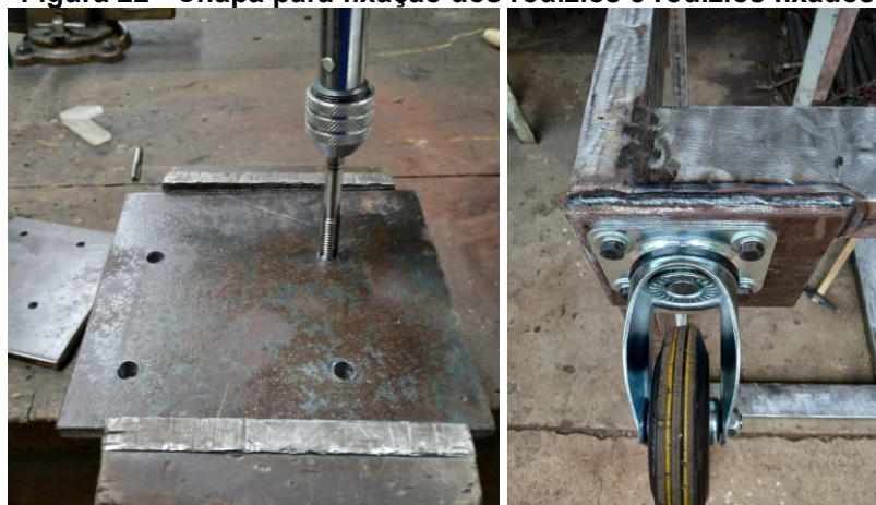
Figura 22 - Chapa para fixação dos rodízios e rodízios fixados
