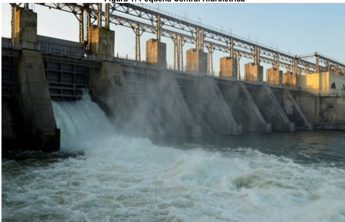
Figura 1: Pequena Central Hidrelétrica
