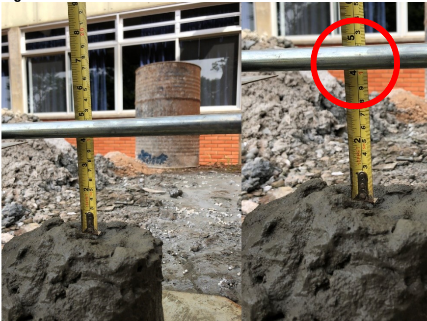
Figura 19 – Medida do abatimento do concreto referência.
