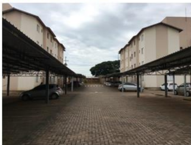
Figura 12- Desnível no terreno
