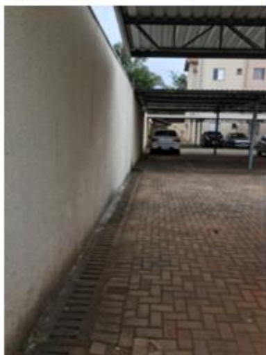
Figura 13 - Canaleta principal ligada à rede pública
