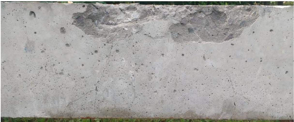
Figura 41: Viga com a armadura de cisalhamento a 90° após 3 impactos – lado A.
