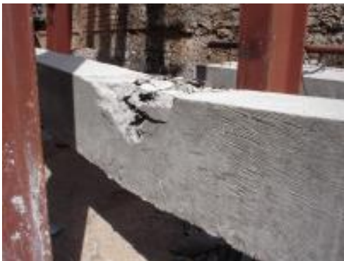
Figura 10: Ruptura da viga com martelo solto a 100 cm.
