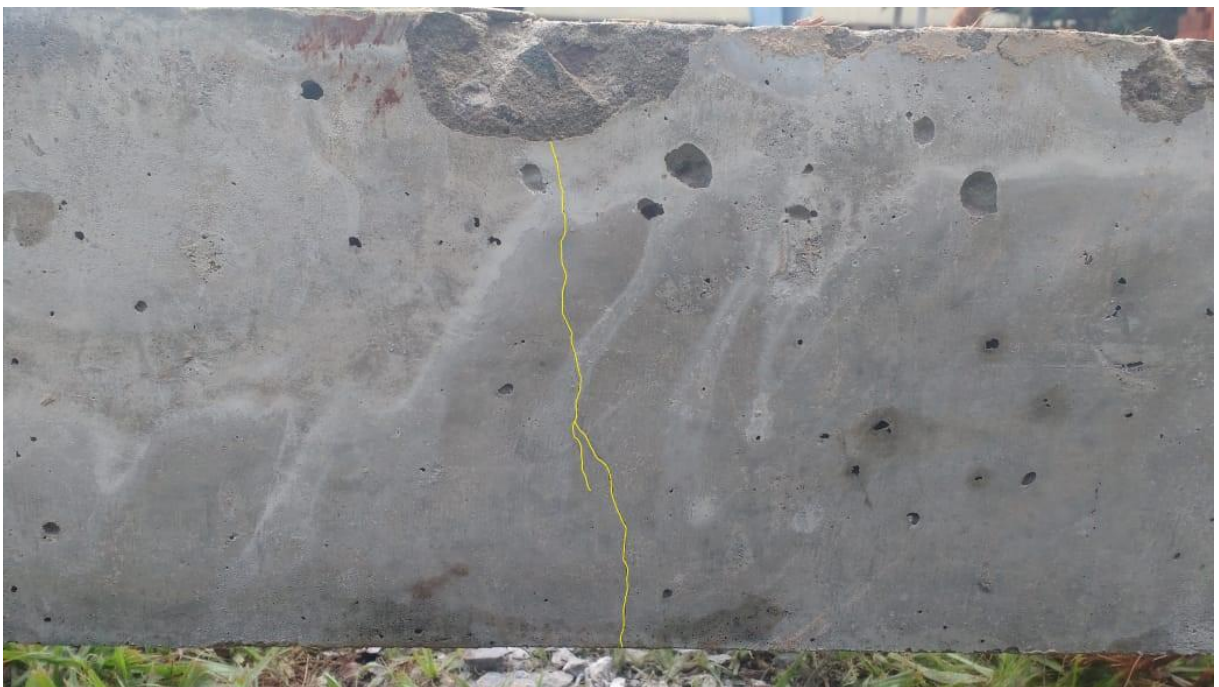
Figura 48: Viga com a armadura de cisalhamento a 45° após 2 impactos – lado B, com a fissura em evidência.
