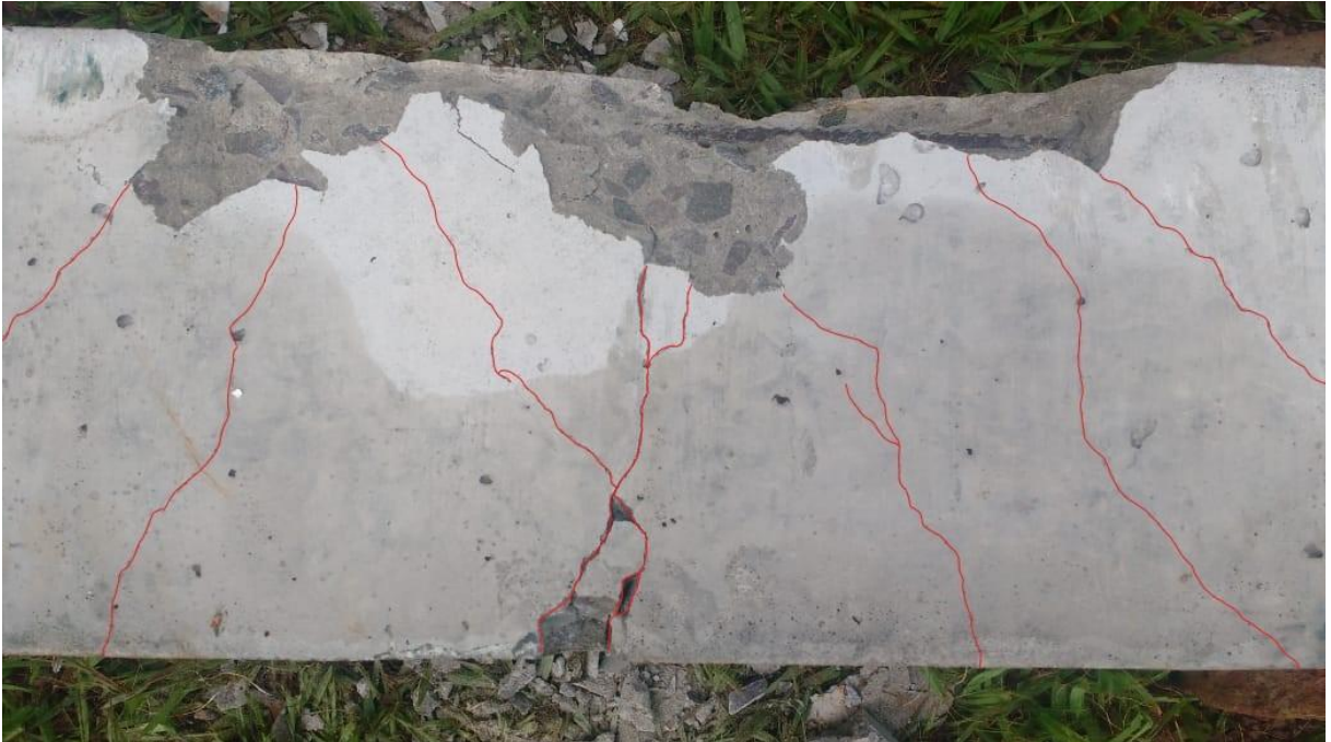
Figura 51: Viga com a armadura de cisalhamento a 45° após 7 impactos – lado A, com as microfissuras em evidência.
