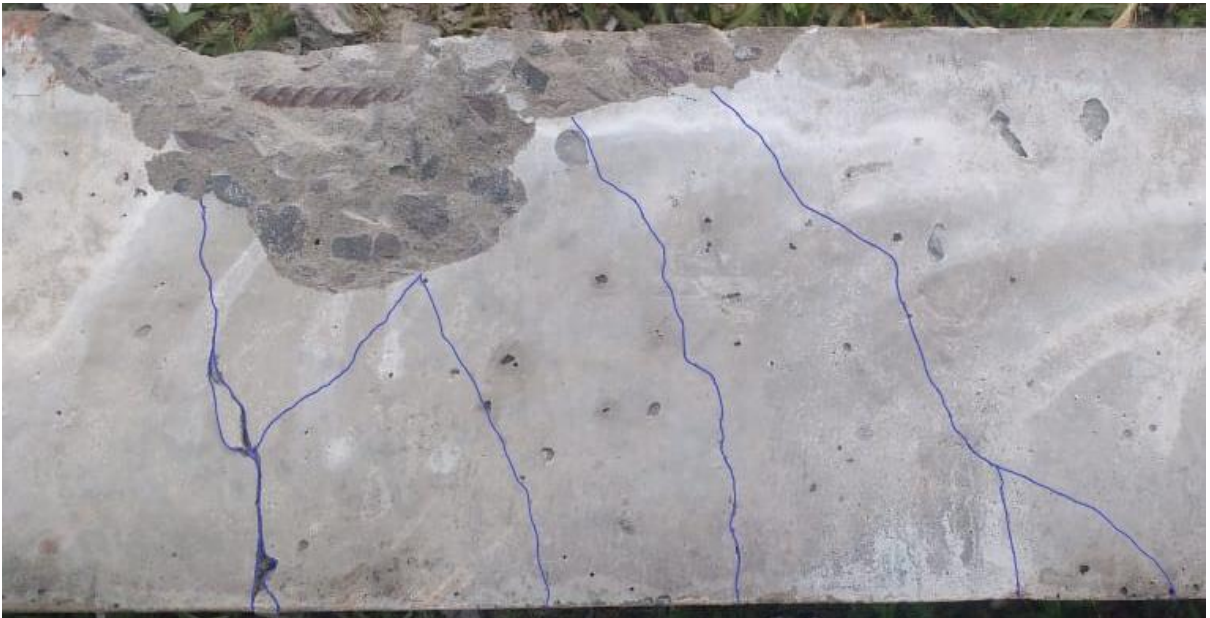
Figura 52: Microfissuras na viga com a armadura de cisalhamento a 45° após 7 impactos – lado B, a direita, com as microfissuras em evidência
