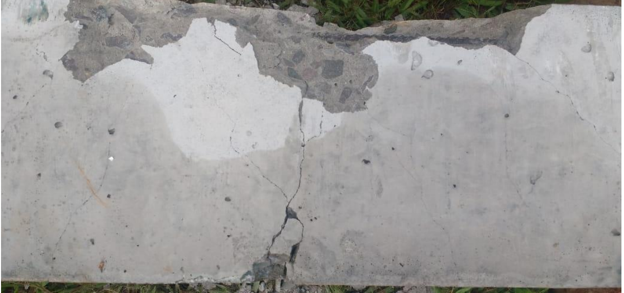
Figura 49: Viga com a armadura de cisalhamento a 45° após 7 impactos – lado A.
