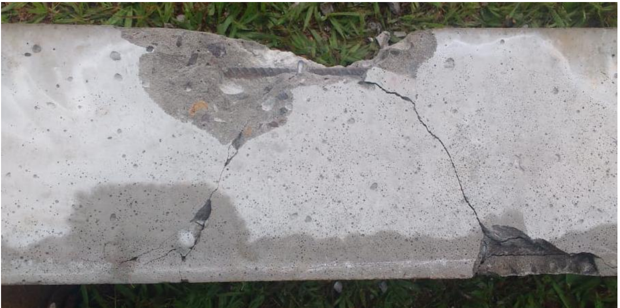
Figura 45: Viga com a armadura de cisalhamento a 90° após 7 impactos – lado B.
