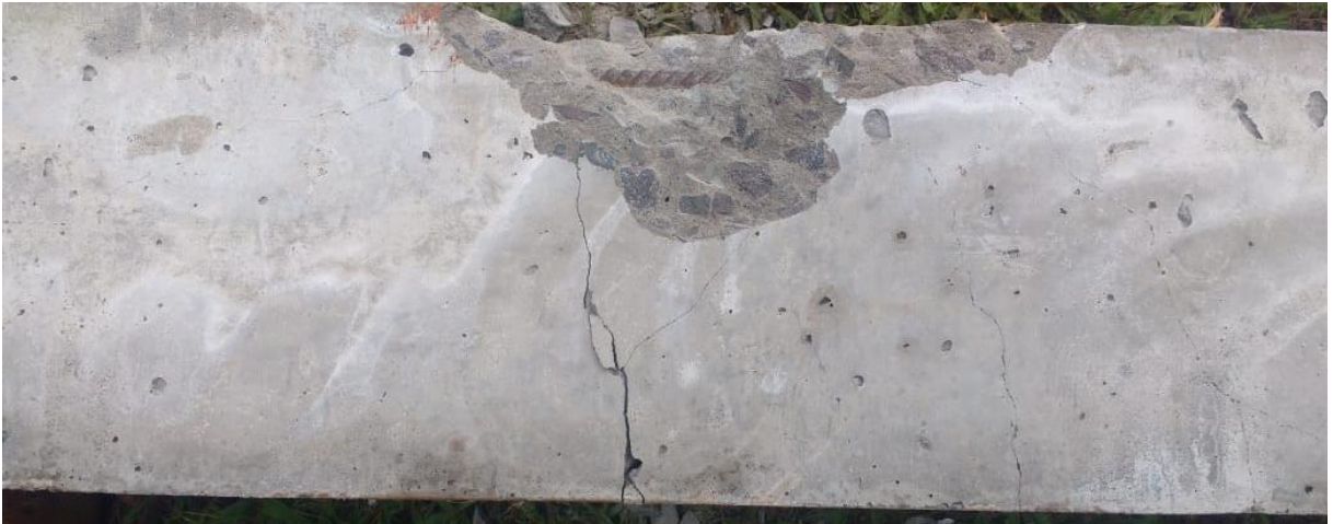
Figura 50: Viga com a armadura de cisalhamento a 45° após 7 impactos – lado B.
