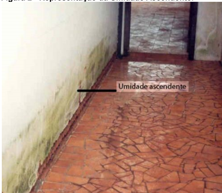
Figura 2 - Representação da Umidade Ascendente.
