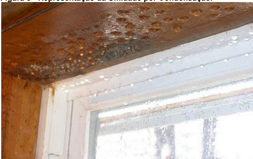
Figura 3 - Representação da Umidade por Condensação.
