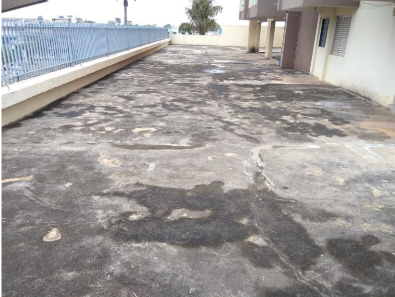
Figura 19 - Laje (c - fundo): Área de Lazer.
