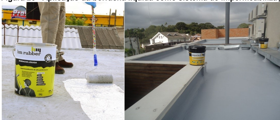
Figura 23 - Aplicação da borracha líquida como sistema de impermeabilização.
