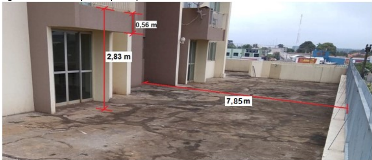
Figura 27 - Medidas para implantação da cobertura.
