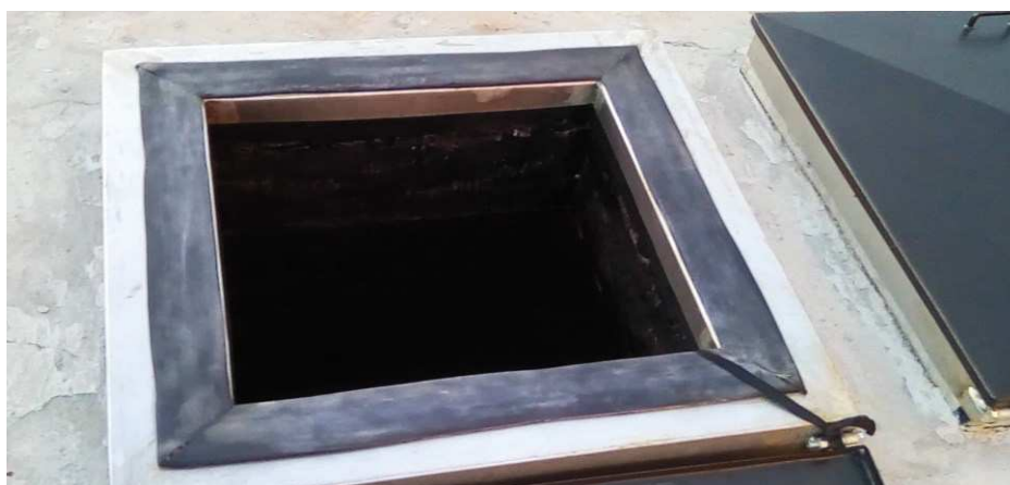
Figura 8 – Abertura de acesso a cisterna
