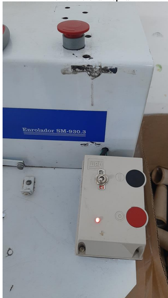
Figura 12 – Nova chave de partida e chave de emergência do enrolador Fonte – Autoria Própria
