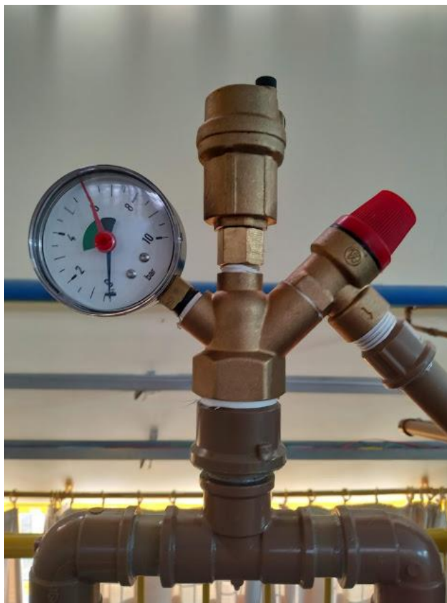
Fotografia 6 - Válvula de segurança e manômetro
