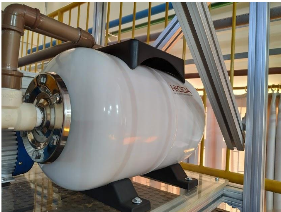
Fotografia 5 - Vaso de expansão
