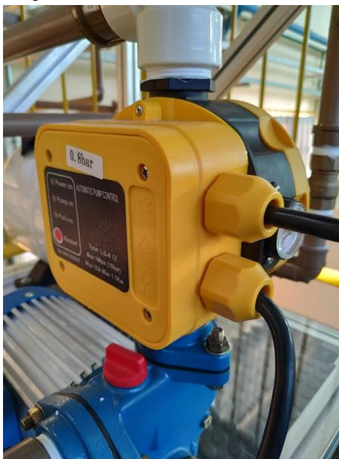
Fotografia 4 - Pressostato
